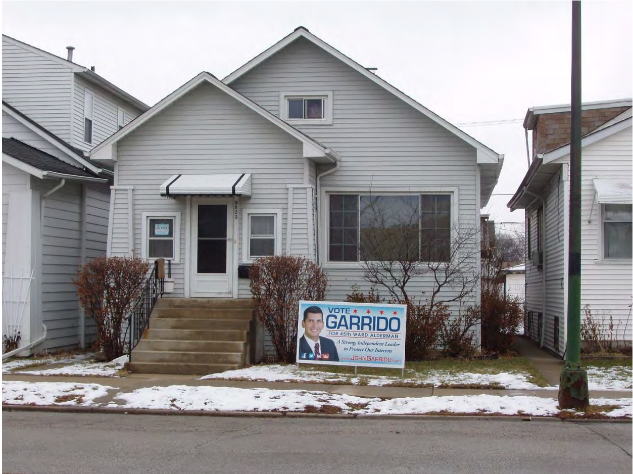
Building 016 - 5823 N. Austin Avenue
