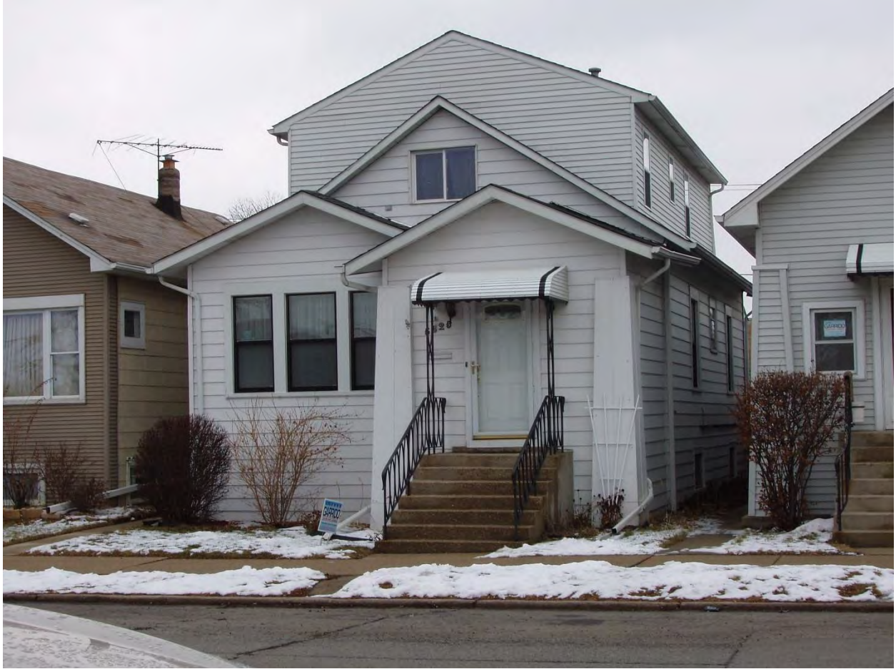
Building 017 - 5825 N. Austin Avenue
