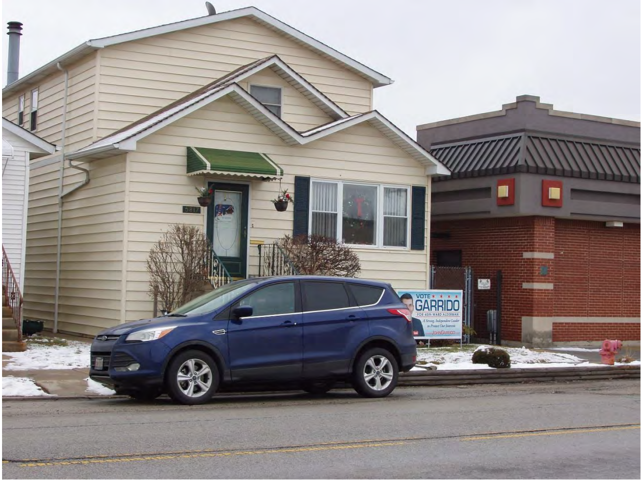
Building 014 - 5817 N. Austin Avenue
