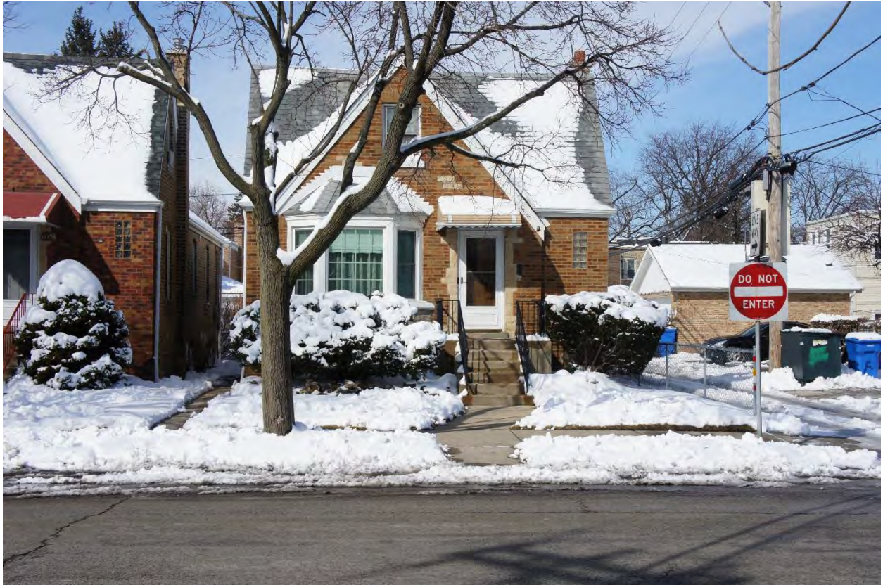
Building 042 - 5744 N. Austin Avenue
