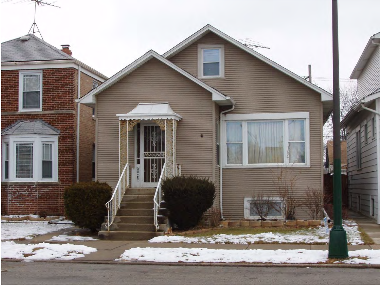
Building 018 - 5829 N. Austin Avenue
