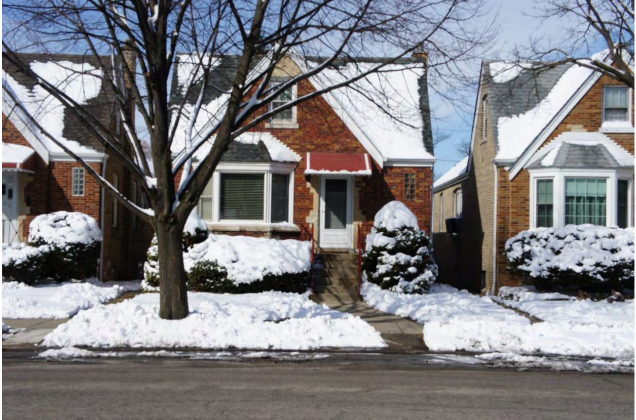
Building 043 - 5740 N. Austin Avenue
